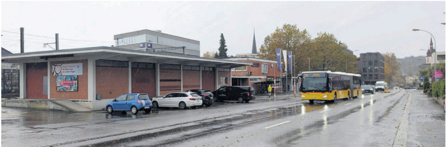
Wohl bald ein Bild der Vergangenheit: Die beiden Bahnhofsgebäude sollen einem Neubau inklusive Bushof weichen. Die Zürcherstrasse daneben soll bald aufgewertet, entschleunigt und begrünt daherkommen. Bilder: Marco Huwyler
