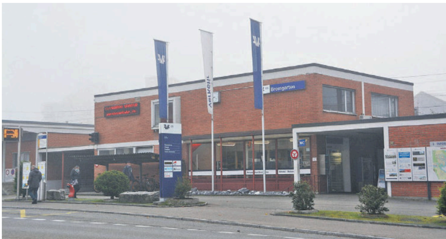
Schon länger ist ein Neubau des Bahnhofs in Planung. Jetzt soll es weiter vorwärts gehen.
