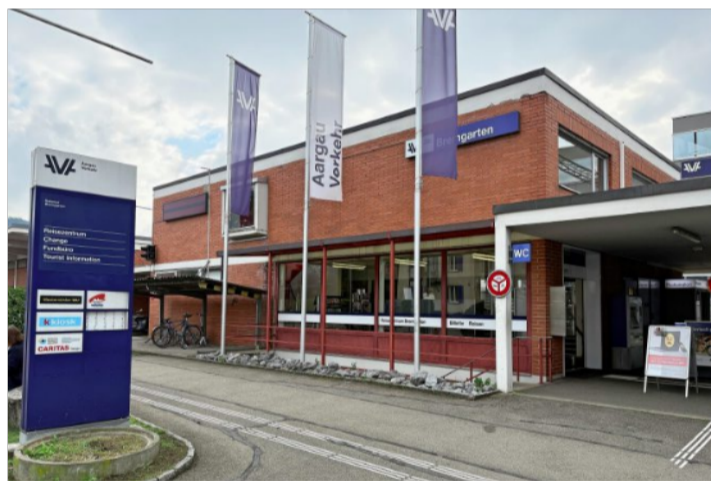
Das Reisebüro und die anderen Bahnhofsgebäude müssen für den Bushof abgerissen werden.
