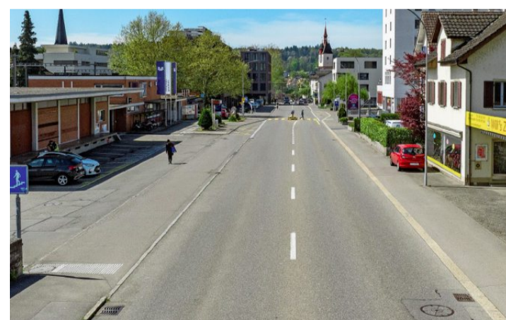
Der gleiche Blickwinkel vor der Sanierung. Bild: zvg
